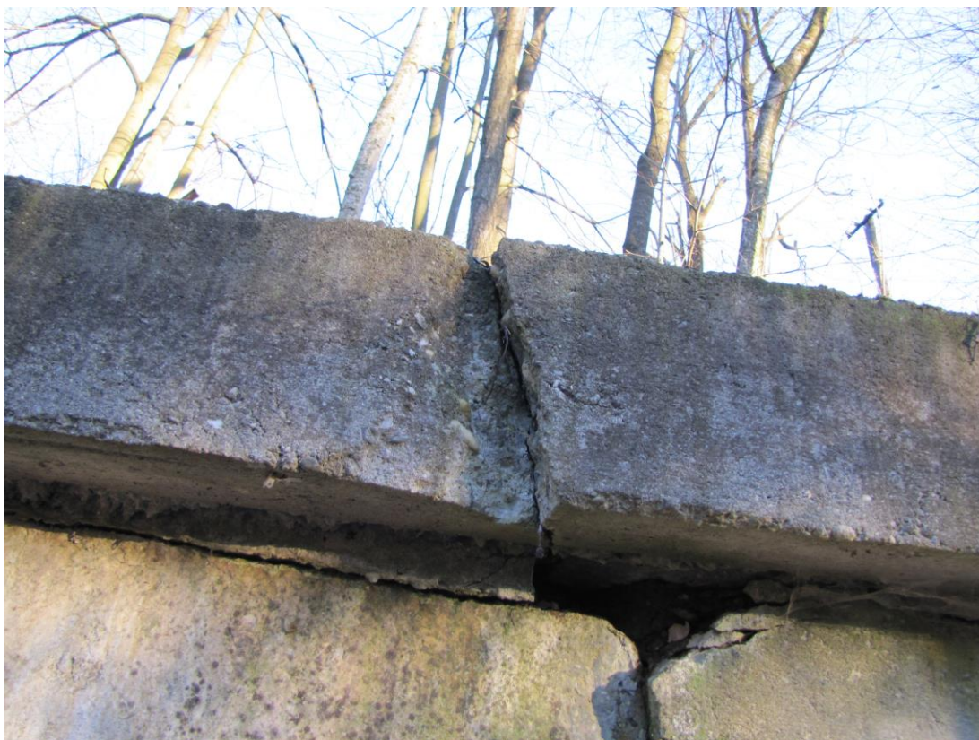
Obr.č.7: Prasklina v římse na návodní straně.
