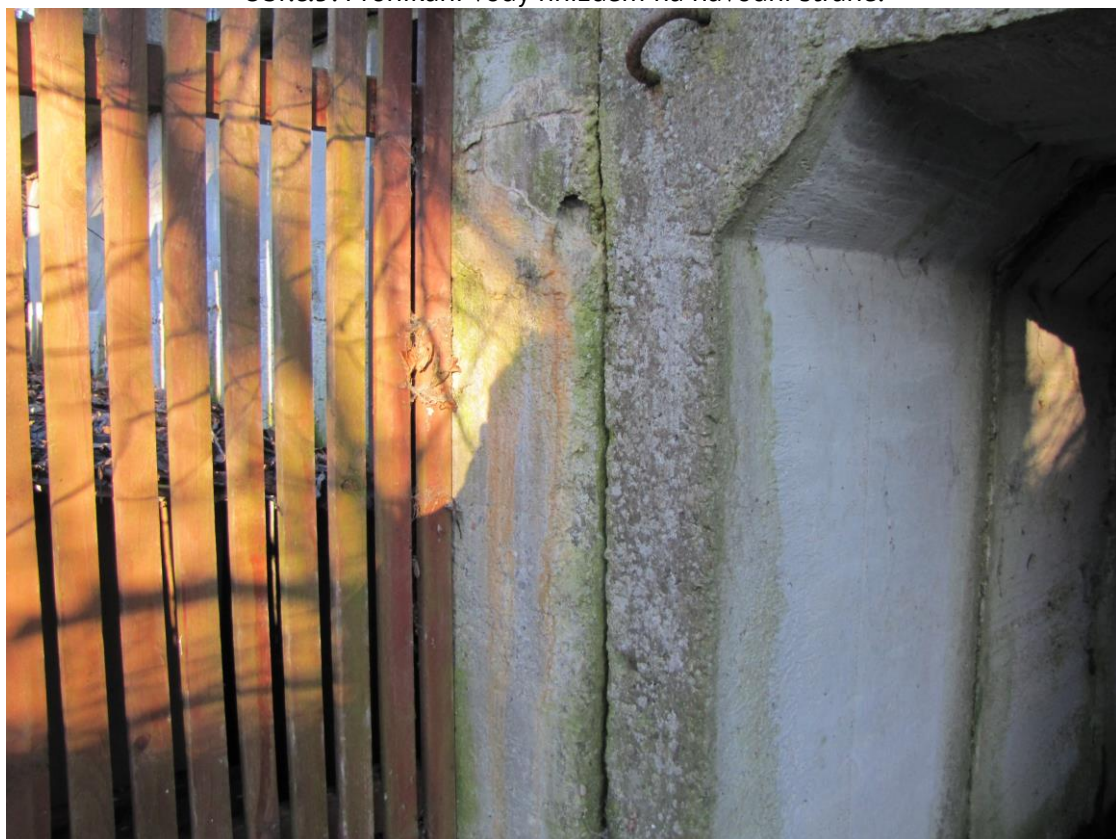
Obr.č.6: Návodní čelo - výluhy.
