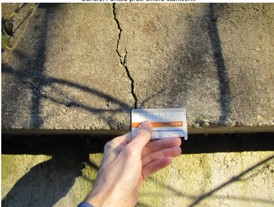
Obr.č.2: Trhlina v římse.
