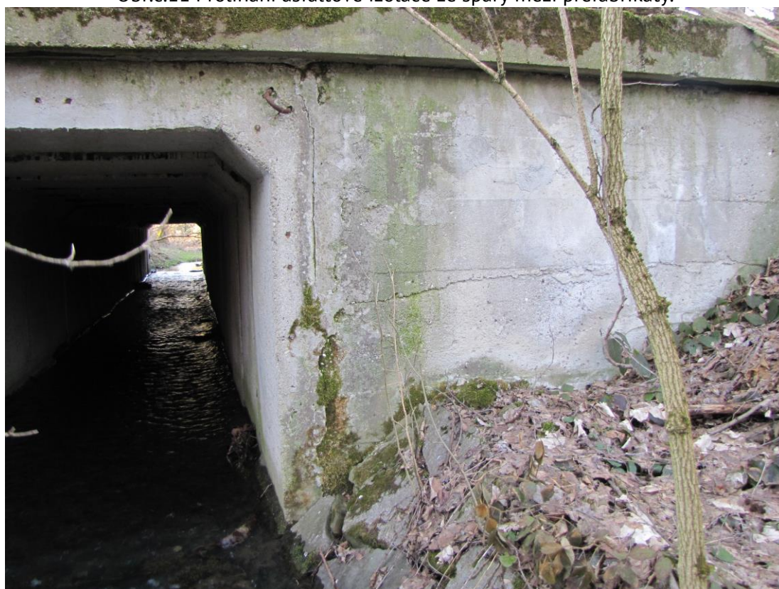
Obr.č.12 Povodní čelo - výluhy.
