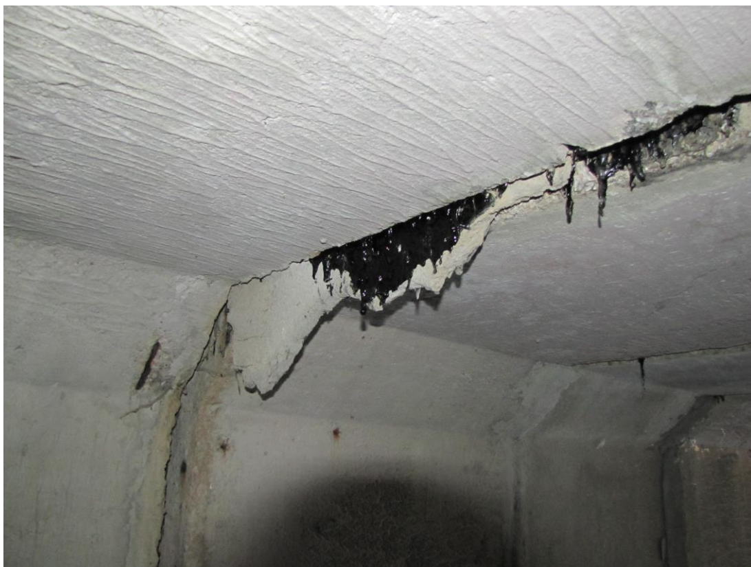
Obr.č.11 Prolínání asfaltové izolace ze spáry mezi prefabrikáty.
