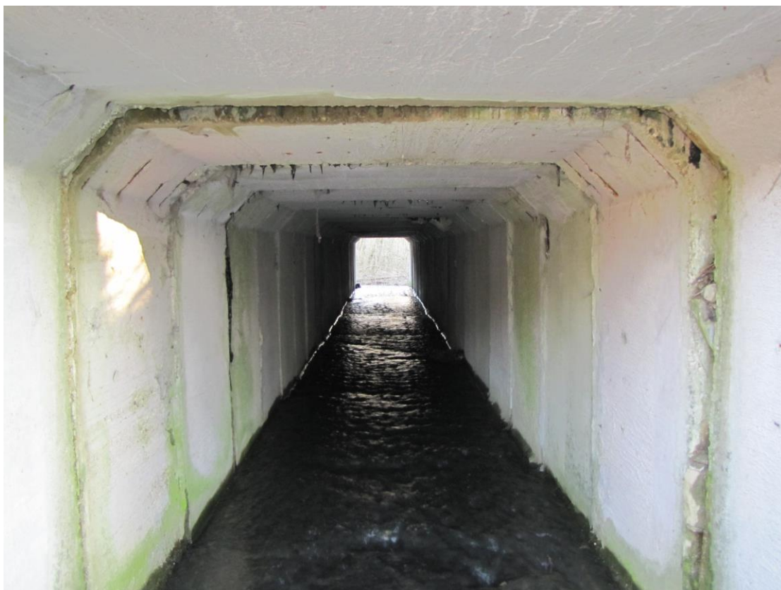
Obr.č.9 Průsaky netěsnými spárami
