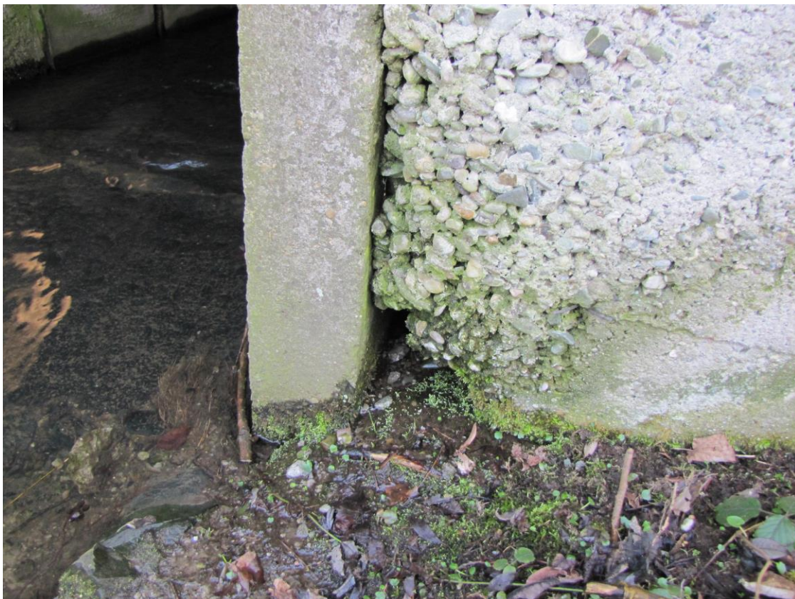
Obr.č.5: Pronikání vody hnízdem na návodní straně.
