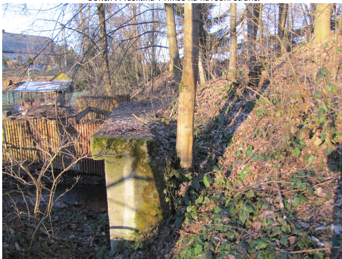
Obr.č.8: Degradace v římse působením vegetace
