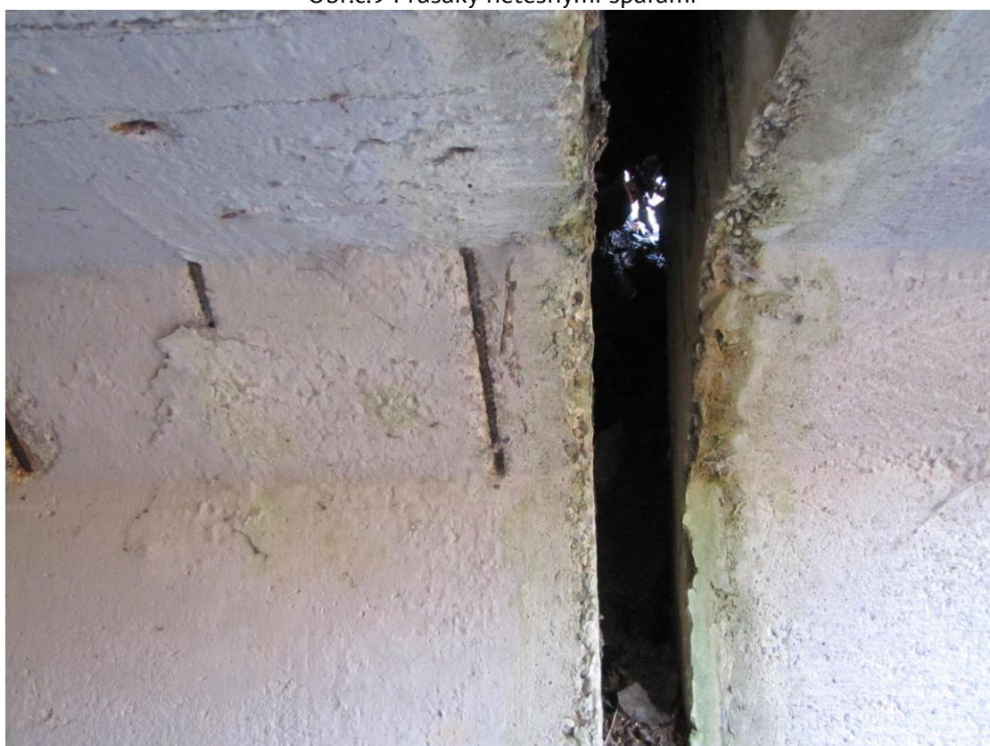
Obr.č.10 Otevřená spára mezi prefabrikáty.
